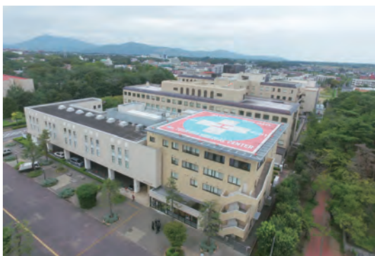
① 筑波メディカルセンター病院 地域医療支援病院 救命救急センター 茨城県地域がんセンター 災害拠点病院 臨床研修病院 筑波剖検センター
