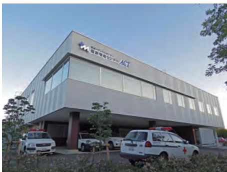
メディカルプラザ外観
