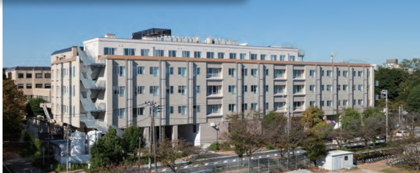
病院3号棟外観
